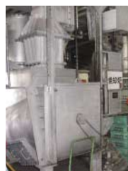
静岡工場 焼却炉 (廃止・撤去)
