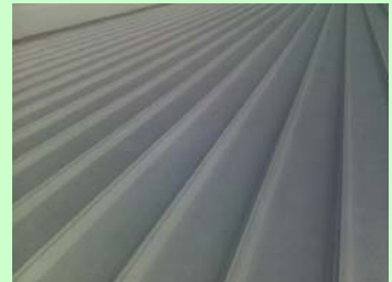
屋根部への断熱塗装後
