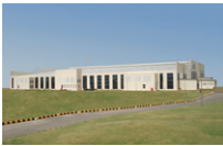
IJL パワール工場
