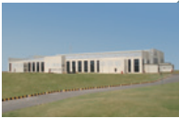
IJL パワール工場
