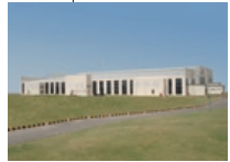
IJL パワール工場
