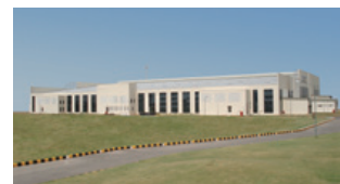
IJL パワール工場
