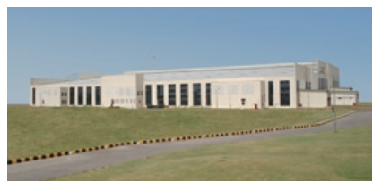
IJL パワール工場
