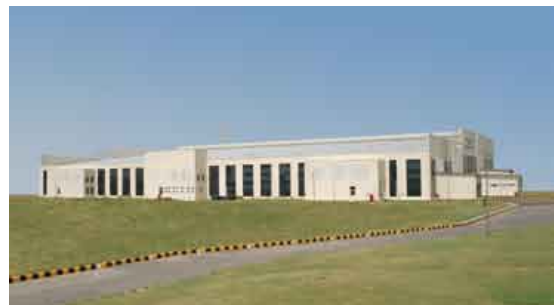
IJL パワール工場
