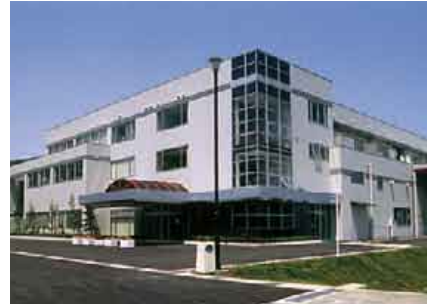
小糸製作所 富士川工機工場
