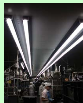
縦方向に一直線につなげた 組立工程設置例
