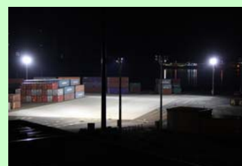
新潟港 西ふ頭ヤード 全景(夜間)
