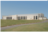
IJL パワール工場
