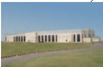
IJL パワール工場
