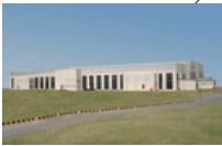
IJL パワール工場
