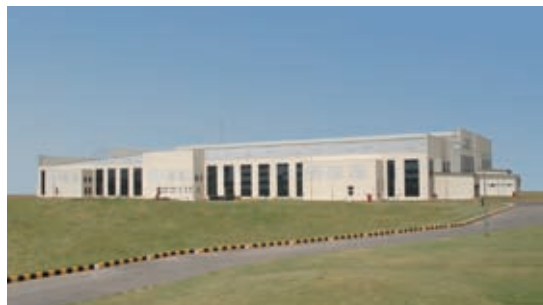
▶ IJL パワール工場
