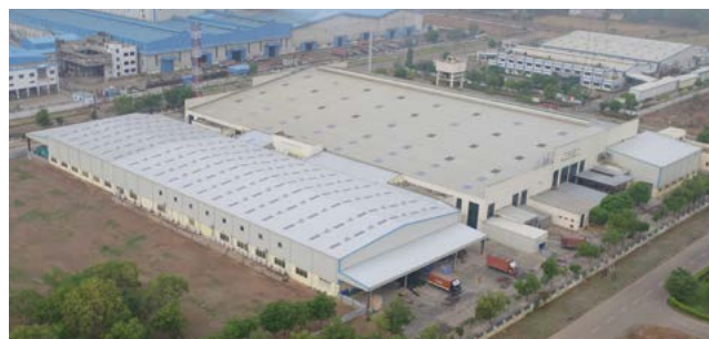
IJL パワール工場
