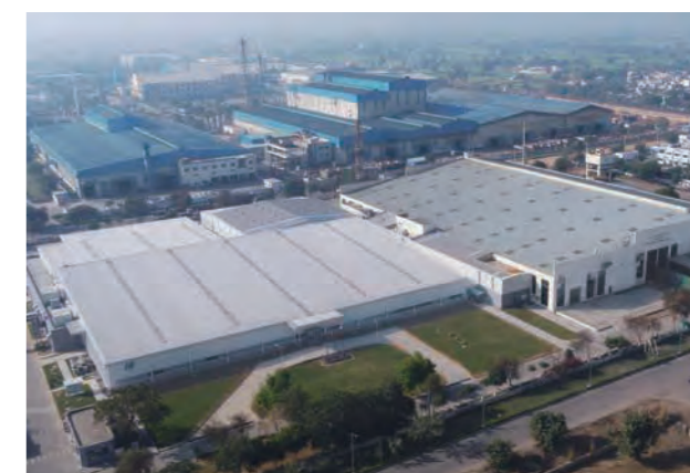
■ IJL パワール工場
